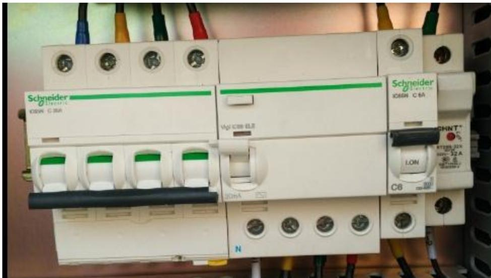
开关扳手在下为断开状态，在上为通电状态。当对系统进行通电的时候，请确认模式调节钮是否在停止位置。
